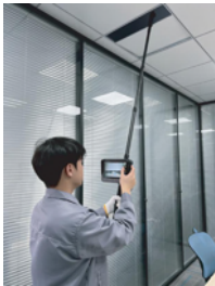
天花板管道检查
